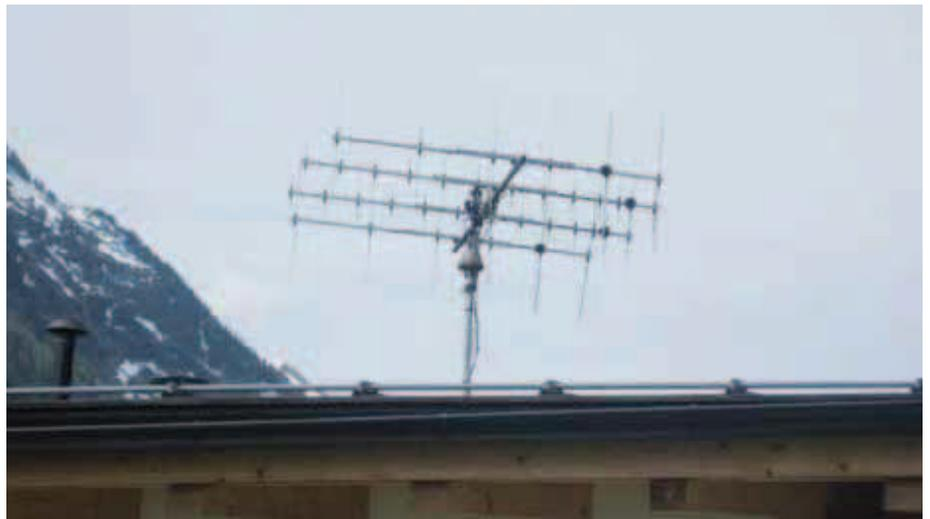
Die Richtantennen für 70 cm und 2m auf dem Dach, welche horizontal und vertikal schwenkbar sind
